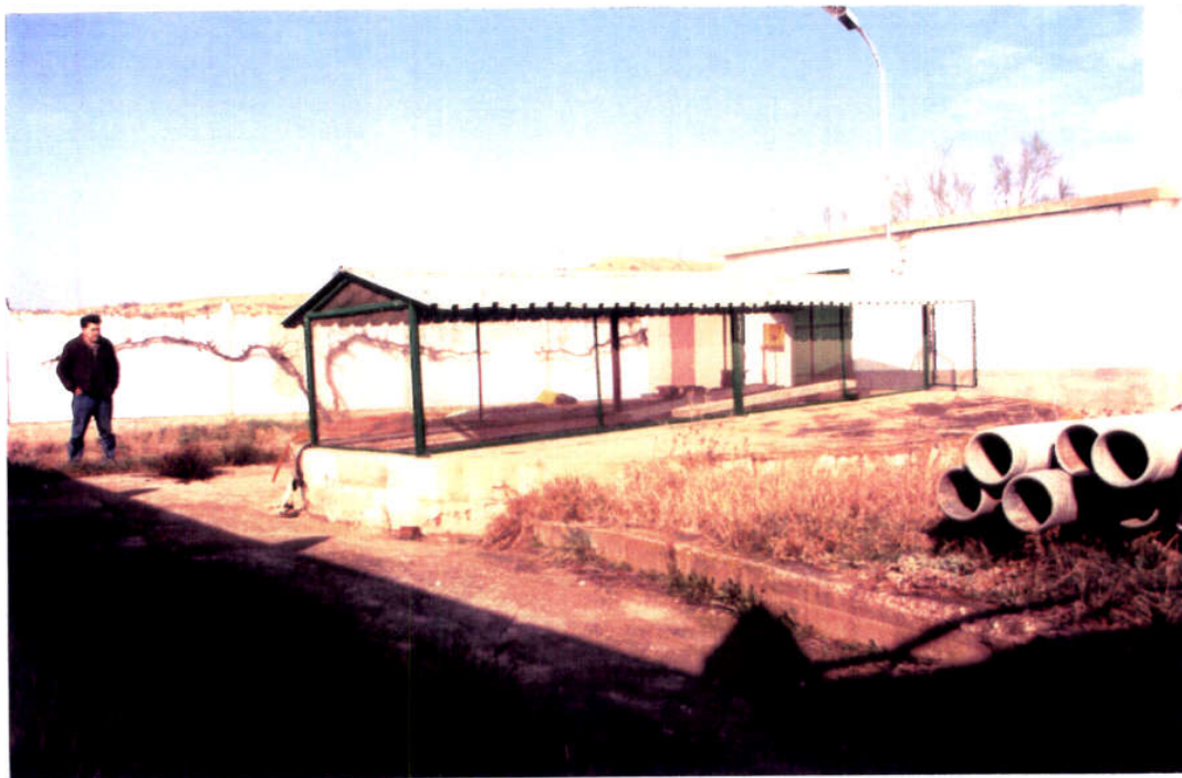
FOTO 2: Captación de aguas subterráneas.
